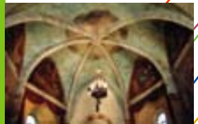
Voûte du sanctuaire à cinq pans du XIV e siècle - peintures murales du XVIII e siècle.
